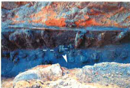
Abb. 4. Die Spundwände wurden im Laufe ihrer Nutzungszeit mehrfach erneuert. Hier kann man neben einer Reihe gut erhaltener Spundpfähle im Planum die Stümpfe einer weiteren Pfahlreihe erkennen.
