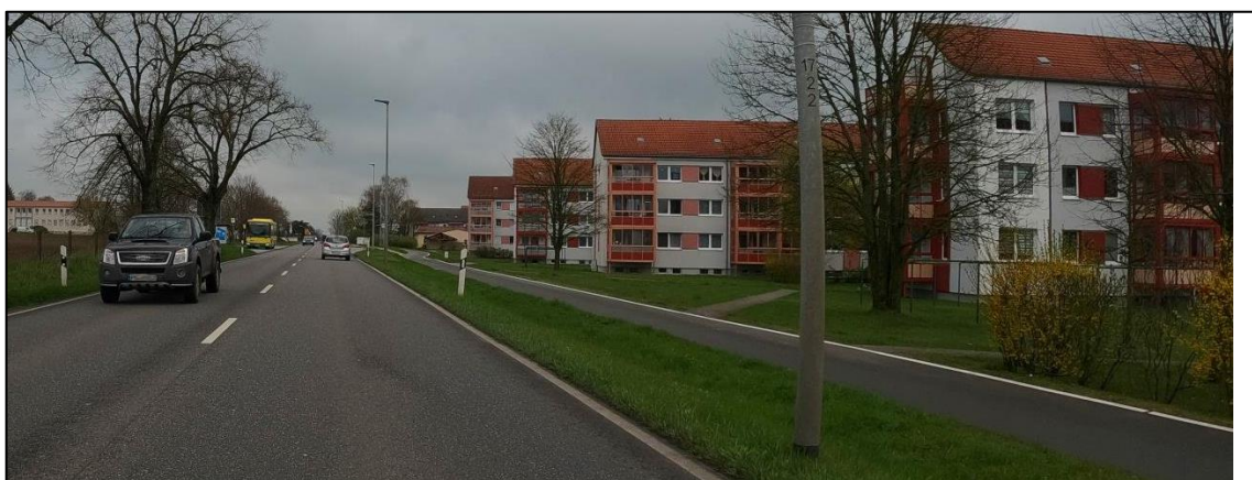
Abb. 17 Bestandssituation Lübzer Chaussee
