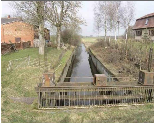
Abbildung 5: Wehranlage Paarsch vor dem Rückbau (Foto: WBV Mittlere Elde Parchim)
