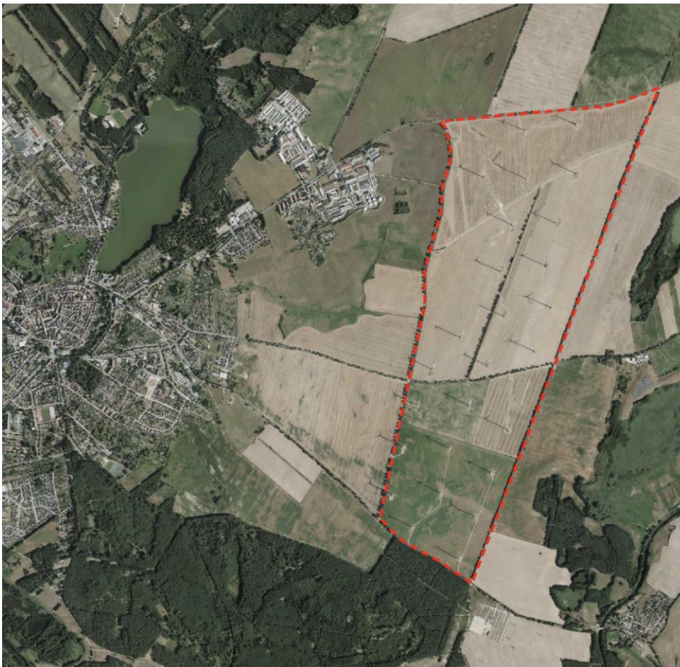
Abbildung 1: aktuelles Luftbild (Quelle: GeoBasis-DE/M-V 2024) mit eingetragenem Plangeltungsbereich
