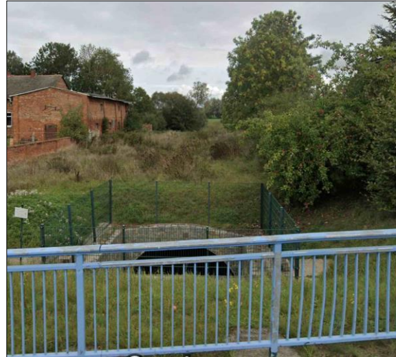
Abbildung 6: heutiger Zustand im Bereich des ehemaligen Wehrs (© 2024 Google, aufgenommen Okt. 2023)
