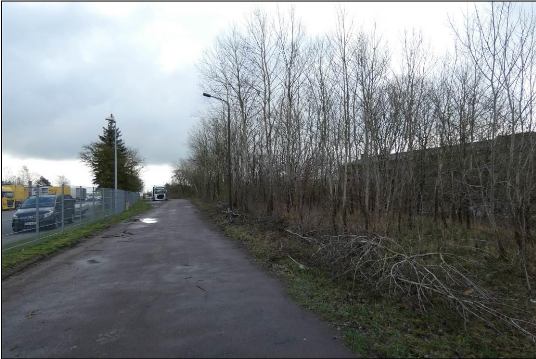
Abbildung 3: Ansicht des südlichen Randes des Plangeltungsbereiches in Richtung Bahndamm. Der Bereich ist im Verbuschen begriffen.
